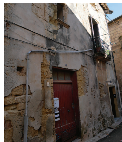
Vigilance sur les techniques de réhabilitation au regard des techniques constructives du bâti - pierre appareillée - moellons enduits
